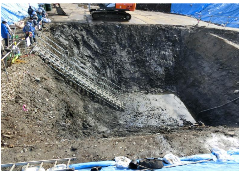
10月21日 掘削完了(深さ 約8. 0m)
