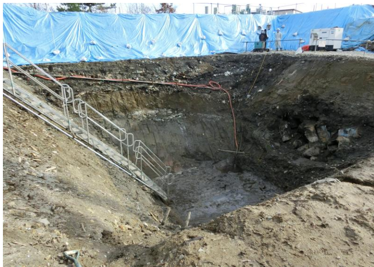
11月22日 掘削完了(深さ 約 9. 0m)
